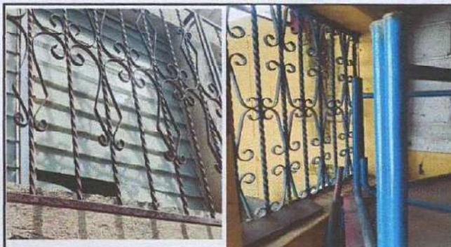
Foto 3: Las ventanas se encuentran en mal estado y hay unas que solamente tienen los balcones, es necesario el reemplazo de las ventanas por ventanas de paleta.
