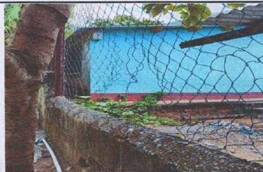
Foto 10: Sustitución de malla galvanizada y reparación de muro de block en circulación perimetral.
